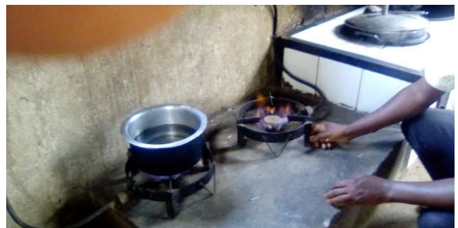
Unsere Biogas-Kochstellen sind bereit für den Einsatz.
